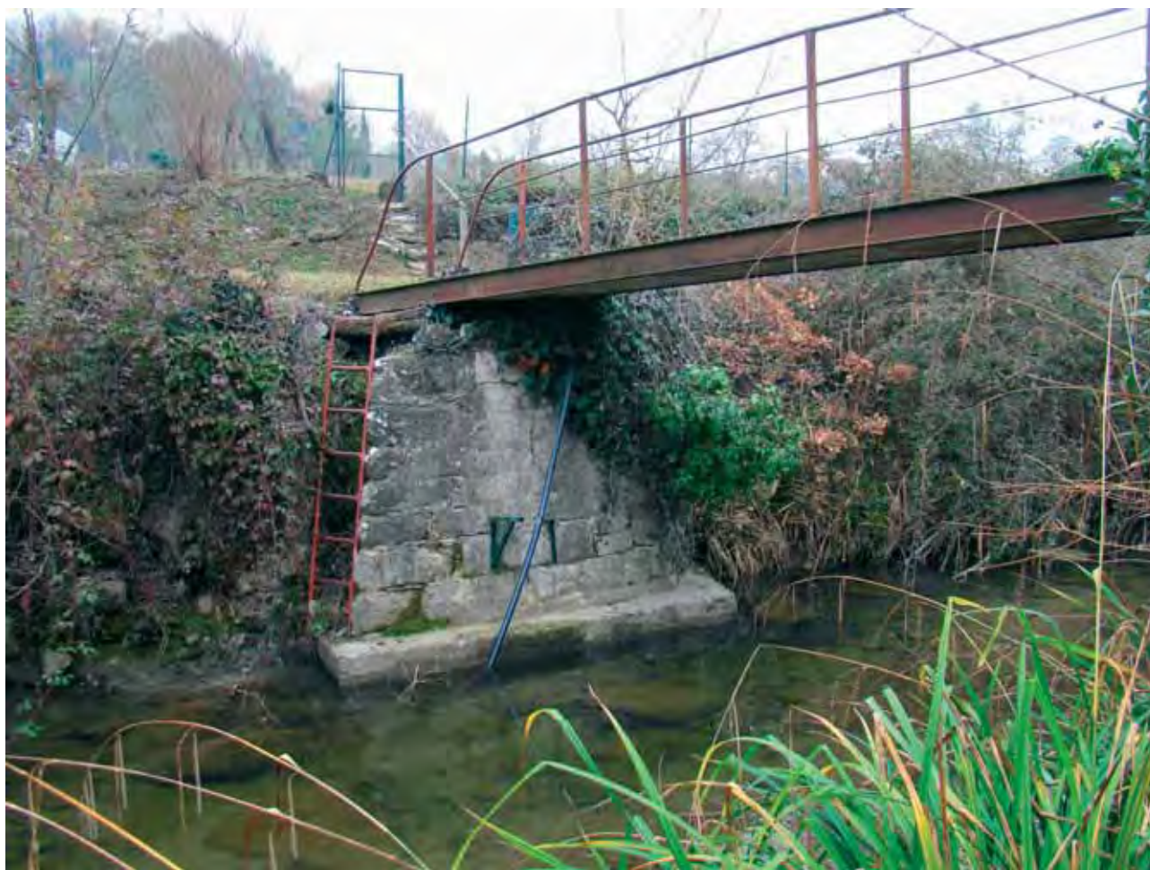
FOTO 18 – Resti di un antico ponte sul Vicano di Pelago nei pressi di Linarino di Sopra. Le vecchie pile furono rinforzate alla base con una colata di cemento. [Punto 15,TAV.1]
