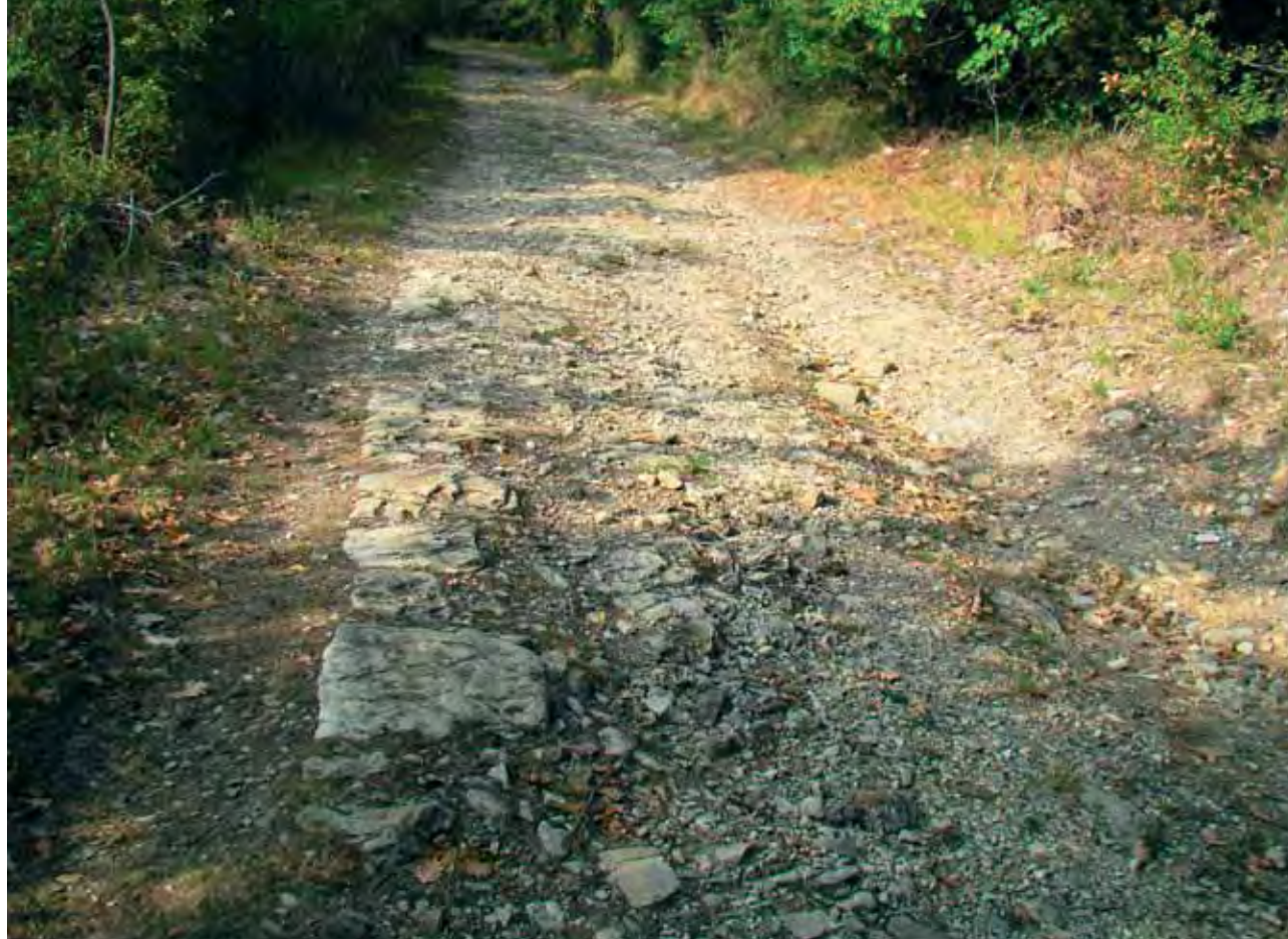
FOTO 2 – Antico tratto di strada fra Le Colonne e l'Alberaccio [Punto 2, TAV.1]
